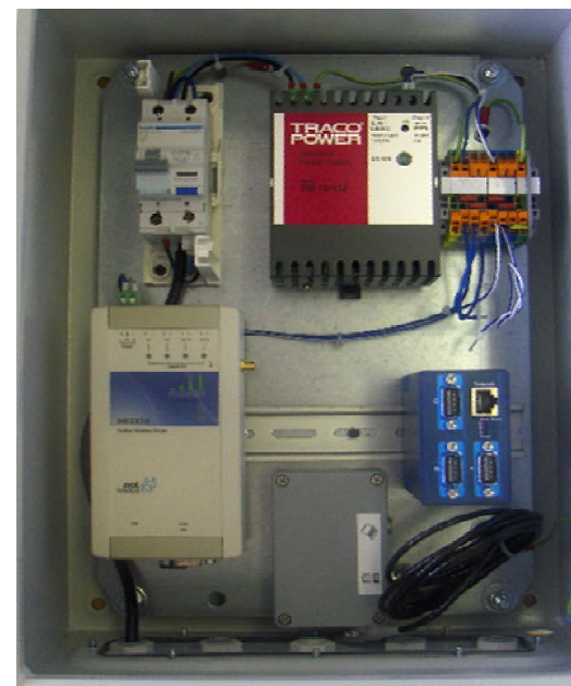
Пример монтажа оборудования
