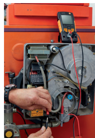
Подготовка к измерению ионизационного тока.
