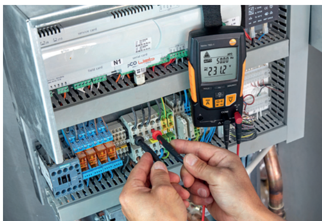
Проверка напряжения в щитке автоматике теплового насоса.
