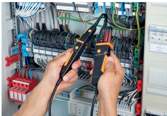
Измерение напряжения в распределительном щитке.
