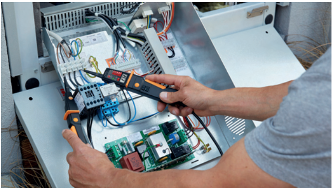
Измерение напряжения на компрессоре.
