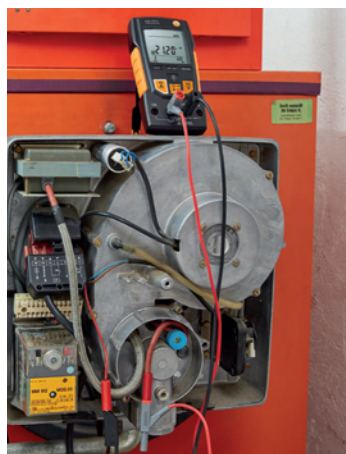
Измерение потока ионизации с testo 760.
