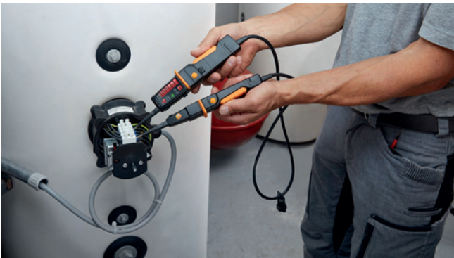
Измерение напряжения на бойлере.
