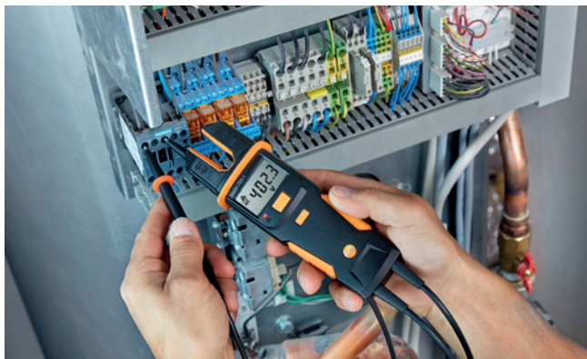
Проверка напряжения на тепловом насосе с testo 755.
